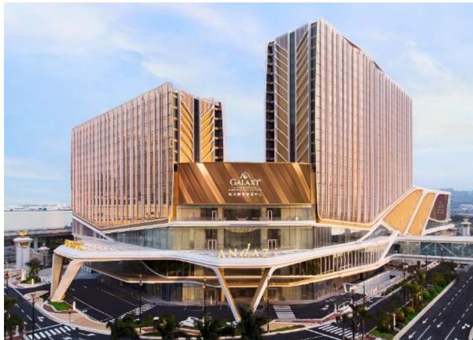
银河国际会议中心、银河综艺馆及安达仕酒店大楼的最新照片 (2023年4月)
