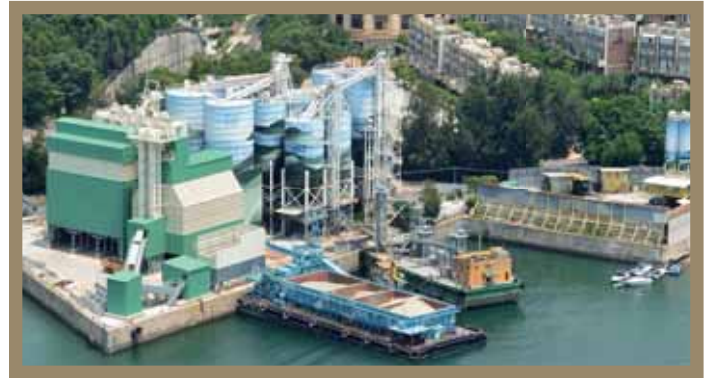
大埔新旗艦混凝土生產設施
