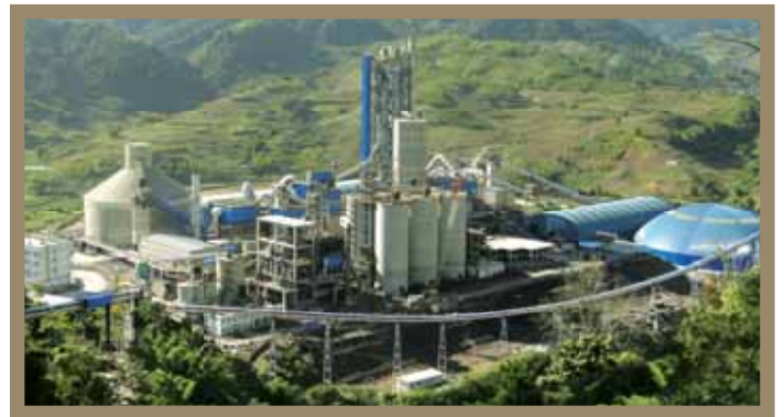
雲南省普洱市正在興建的水泥生產廠房
