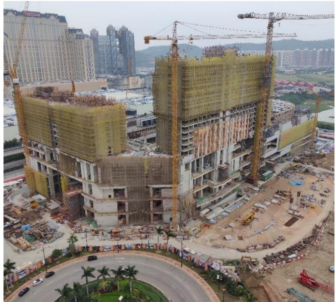
第三期項目照片拍攝於 2020 年 2 月。建築物已平頂，現正進行外牆工程及內部裝修。
