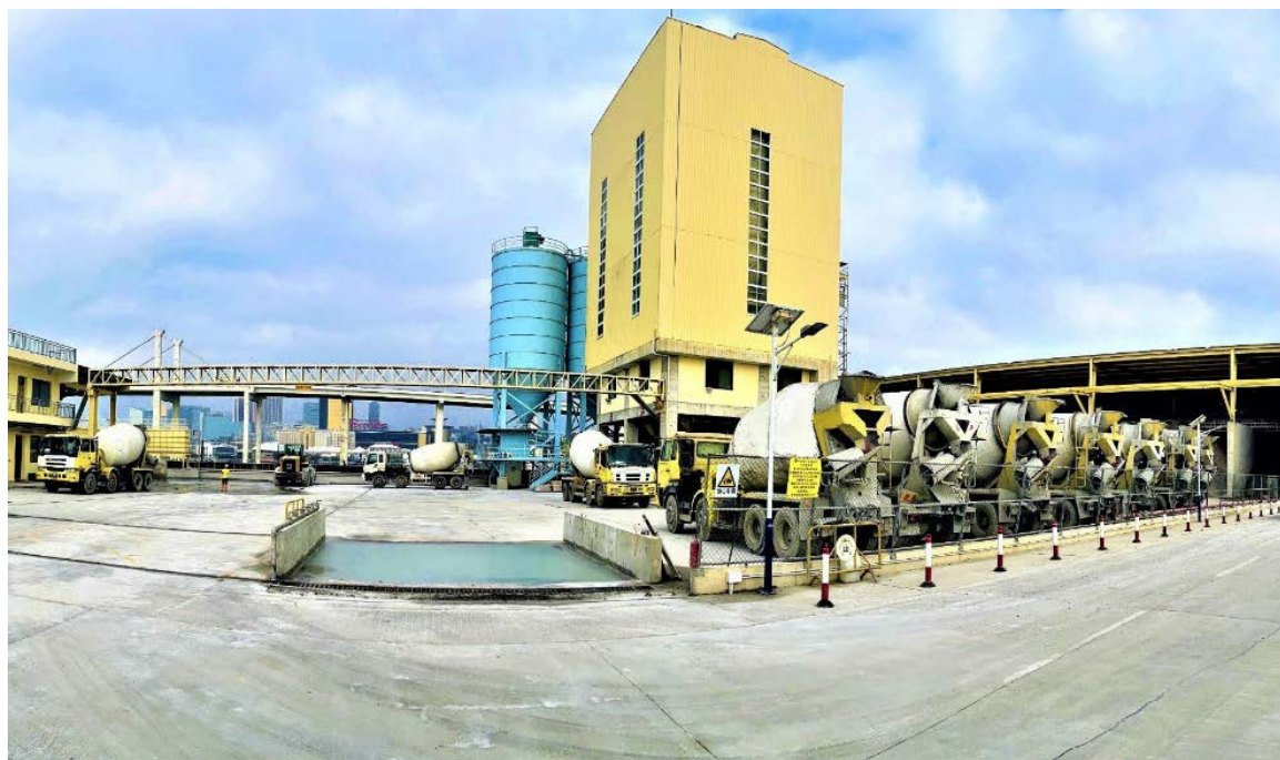
位於澳門新城區A的混凝土廠
