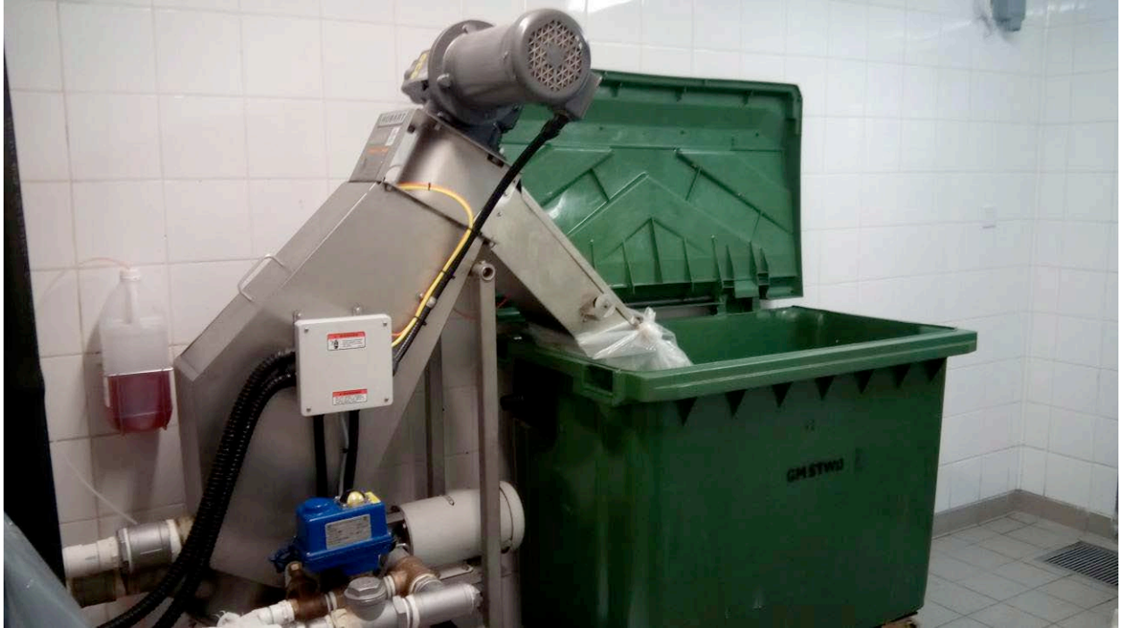
P003：銀娛引入先進的廚餘脫水機，將在員工餐廳收集到的廚餘脫水，可以減少廚餘的重量和體積達八成。
