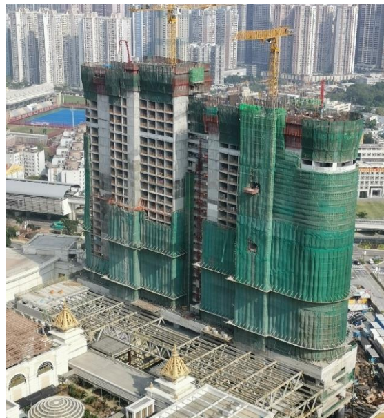
第三期项目照片拍摄于2020年2月。建筑物已平顶，现正进行外墙工程及内部装修。
